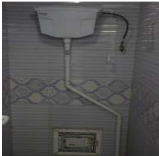
شکل ۹ فلاش تانک دو زمانه
