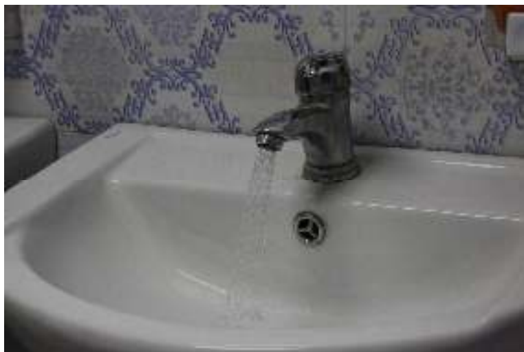
شکل ۱۰ نصب فشارشکن بر روی شیرهای اهرمی
